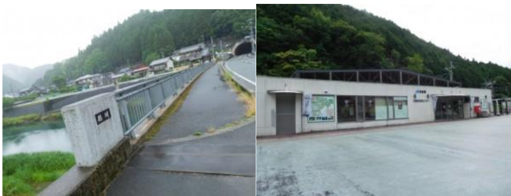
殿田トンネル前
